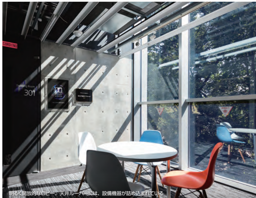
明るく開放的なロビー。天井ルーバーには、設備機器が詰め込まれている
