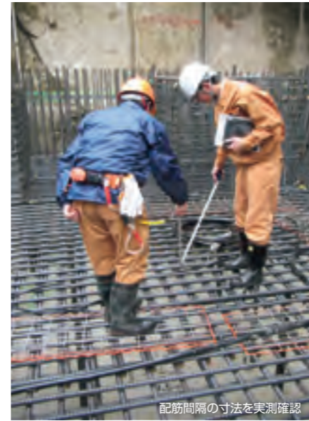
配筋間隔の寸法を実測確認
