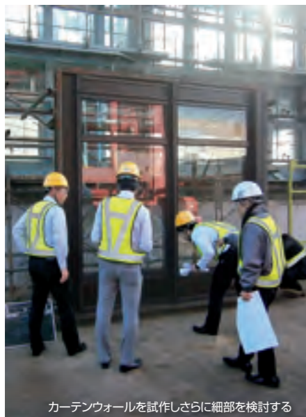
カーテンウォールを試作しさらに細部を検討する
