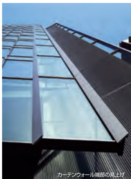
カーテンウォール端部の見上げ
