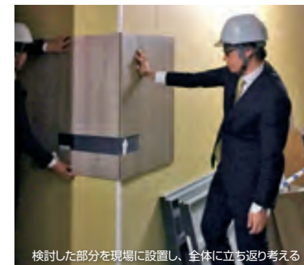
検討した部分を現場に設置し、全体に立ち回り考える
