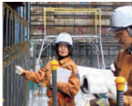
現場で構造設計者が見るところは、竣工後は隠れてしまうところばかり。コンクリート打設前に、設計図書通りに配筋されているかをチェック。実物を見ながら課員に教える良い機会でもある。
