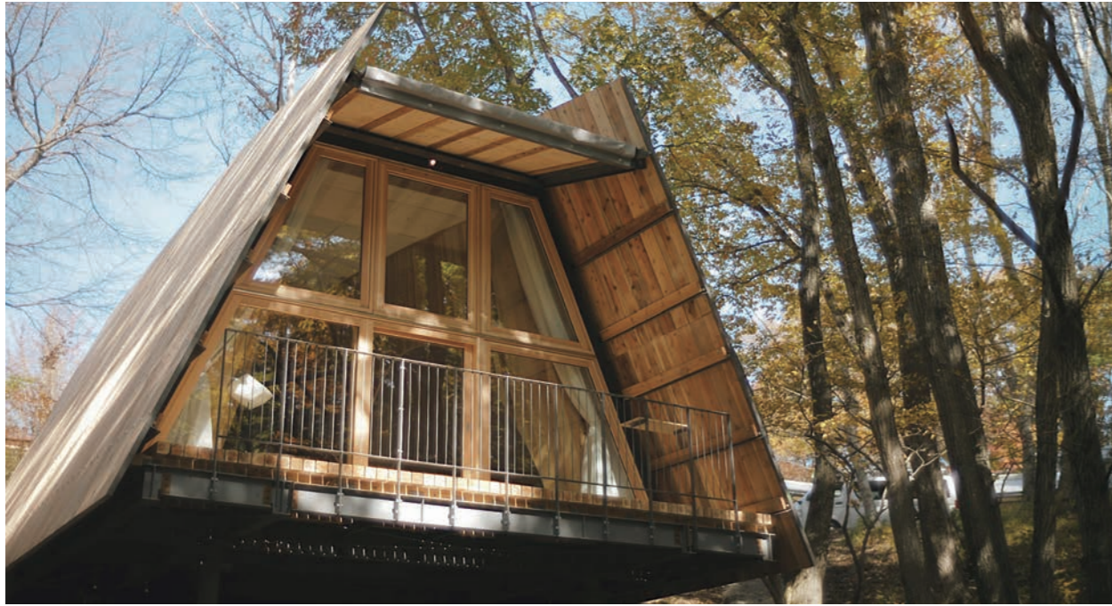
「SANU CABIN」外観（木をできるだけ切らずに、キャビンを設置している）
