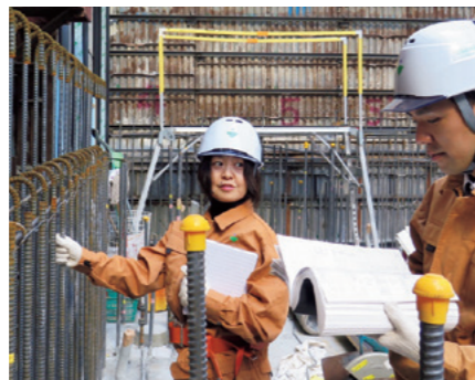
現場で構造設計者が見るところは、竣工後は隠れてしまうところばかり。コンクリート打設前に、設計図書通りに配筋されているかを確認。実物を見ながら課員に教える良い機会でもある。
