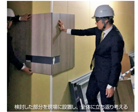
検討した部分を現場に設置し、全体に立ち回り考える
