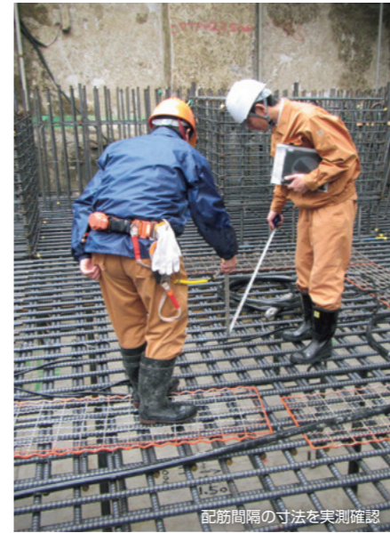
配筋間隔の寸法を実測確認
